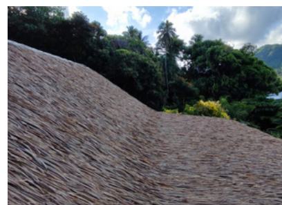
Installation Palmex sur toit existant
