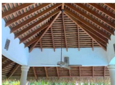
Installation Palmex sur liteaux horizontaux (sans rails)
