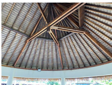
Installation Palmex sur chevrons (avec rails)
